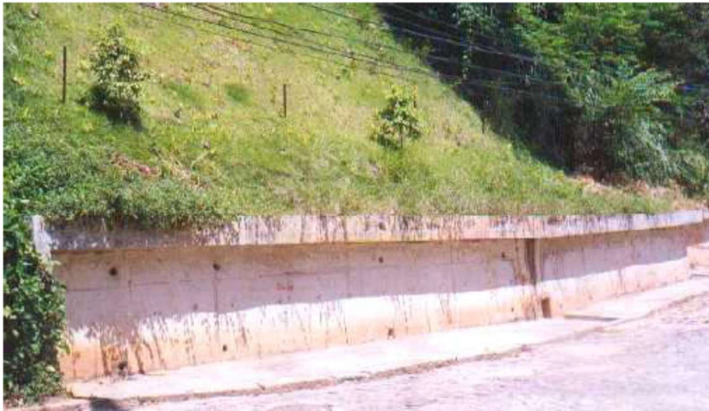
Figura 10 – Muro de concreto armado
