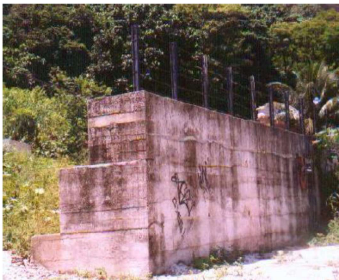
Figura 9 – Muro de concreto ciclópico
